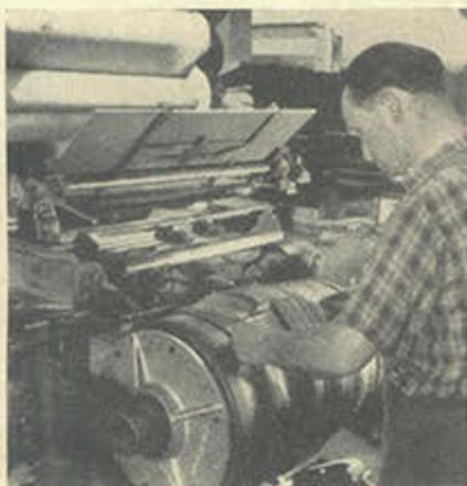
Reifenbauer an einer Pkw-Wickeltrommel. Auf den gewickelten Rohling wird als letztes der Laufstreifen aufgelegt.
