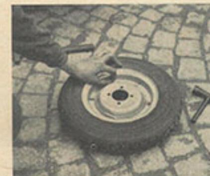
10 Als weiterer Arbeitsgang erfolgt das Zusammensetzen der beiden Felgenhälften und das Verschrauben desselben, wobei darauf zu achten wäre, daß nirgendwo der Schlauch klemmt oder eingezwickelt wird. Das Verschrauben der Mutter erfolgt übers Kreuz.
