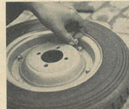
11 Als letzte Arbeit wird der Ventilkegel durch die Rändelmutter am Felgenband festgezogen. Danach kann der Reifen voll aufgepumpt werden. Der Wiedereinbau des Hinterrades erfolgt dann in gleicher Weise wie der Aufbau, nur in umgekehrter Reihenfolge.
